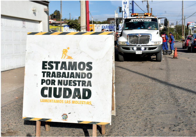
Se trabaja en la consolidación de obras de infraestructura.
