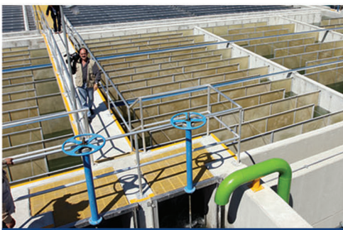
Ampliación de Potabilizadora
