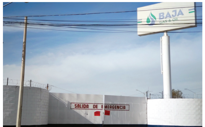
Sellos de clausura fueron colocados en la entrada a la planta de gas.
