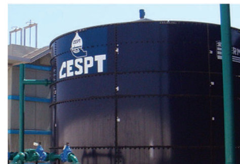
Planta de Tratamiento CAR UABC
