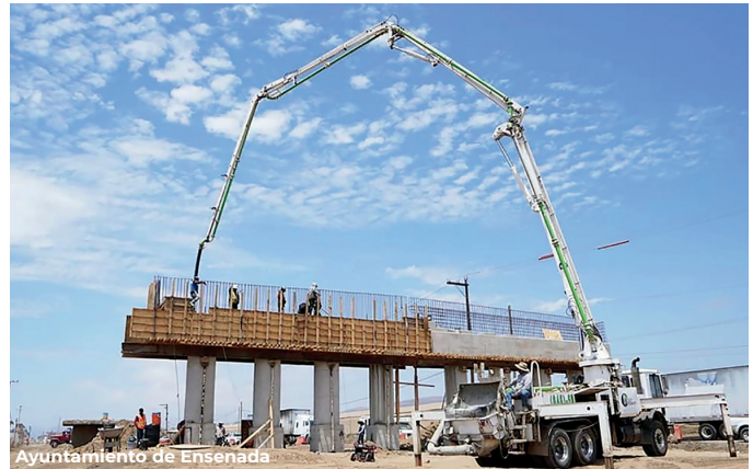
La modernización del tramo carretero Chapultepec - Maneadero registra un avance del 25%
