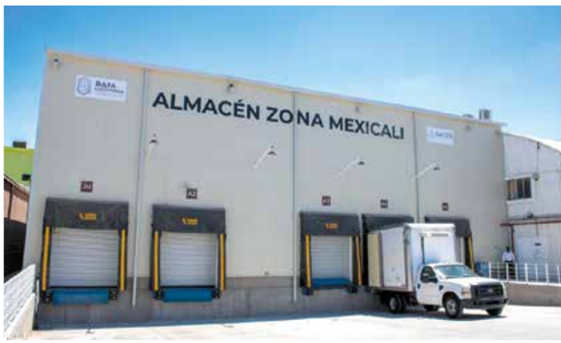
Fachada del almacén en el Ex Ejido Puebla, donde falló el internet y afectó el aire acondicionado.
